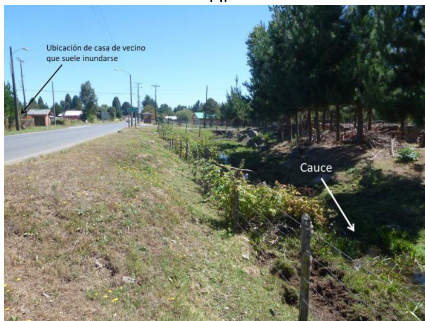
FIGURA N° 4-3 Esquina referida en el Punto F-02 del catastro de inundaciones detallado en el CUADRO N° 4-1.
